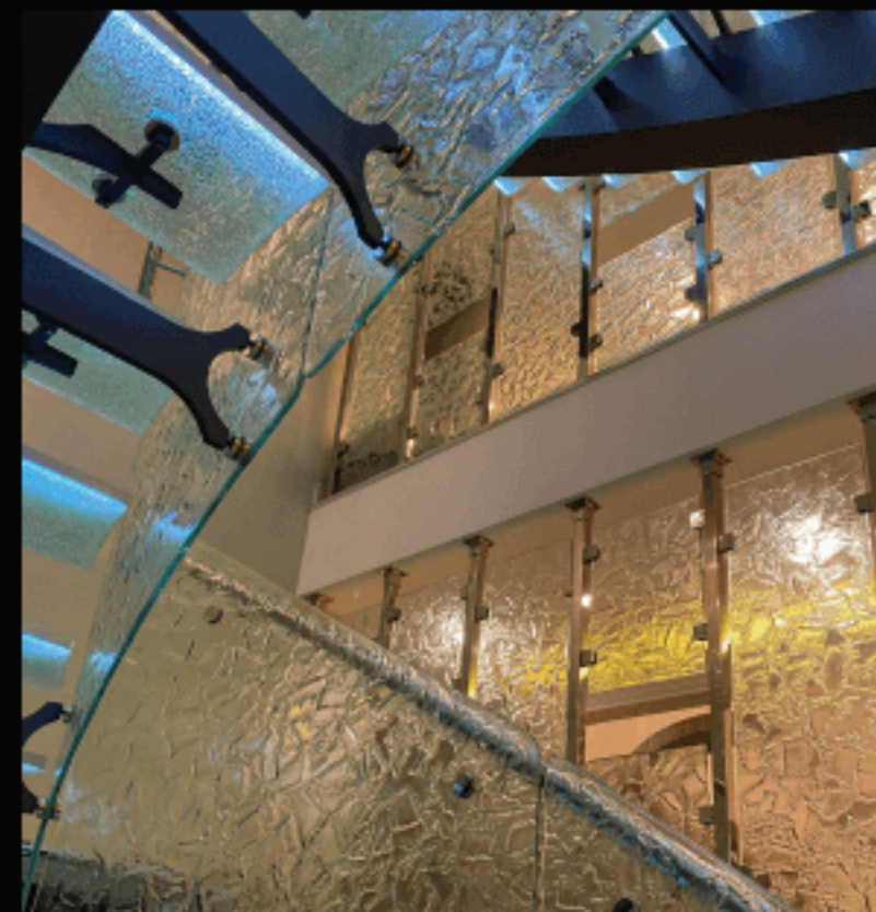
Räcke i böjt smält glas monterat på glashållare
