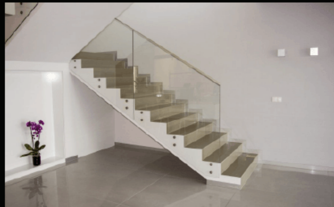
Självbärande räcke i optiwhite laminerat glas monterat på glashållare
